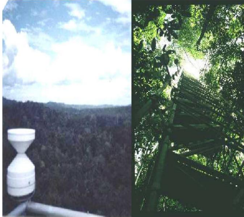
Figura 2.4 - Torre micrometeorológica de 66 metros de altura construída na Reserva Biológica do Jaru (Rebio-Jaru), em Rondônia.
